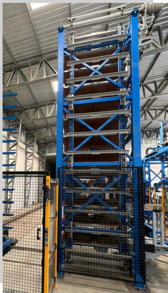
Ascensor de 12 alturas doble bandejas
